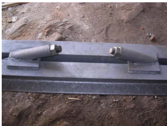
Figura 3. Dettagli delle "graffette" estradosali.
