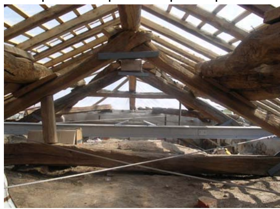
Figura 5. Viste generale dell'intervento nel sottotetto.
