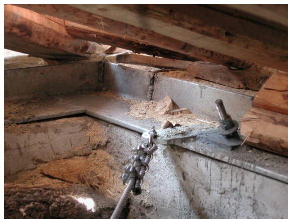
Figura 4. Corrente perimetrale e ancoraggio dei cavi di controvento.
