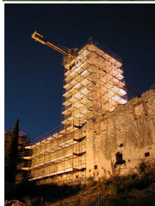
Figura 1. Il Castello di Montorio prima e durante i lavori di consolidamento.
