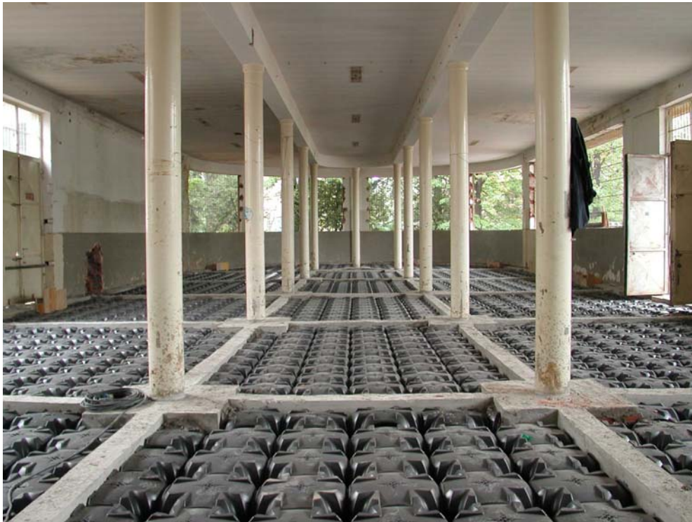
Figura 2. Il "vespaio armato" prima del getto di calcestruzzo.
