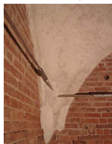
Figura 3. Barre per la cerchiatura interna delle pareti.
