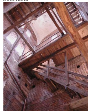
Figura 2.. Vista interna con le scale e i ballatoi in legno
