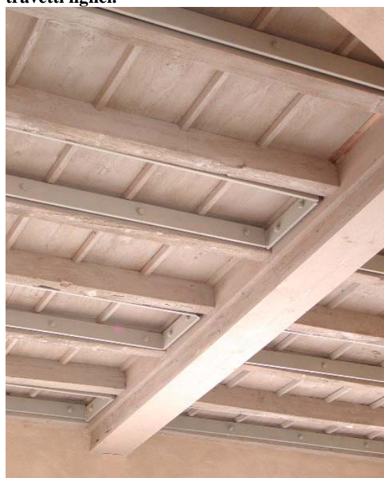
Figura 5. Profili di irrigidimento dei solai cassettonati.
