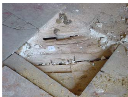
Figura 3. Saggio ispettivo nei pavimenti.
