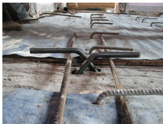
Figura 4. Connettori metallici inghisati nei travetti lignei.
