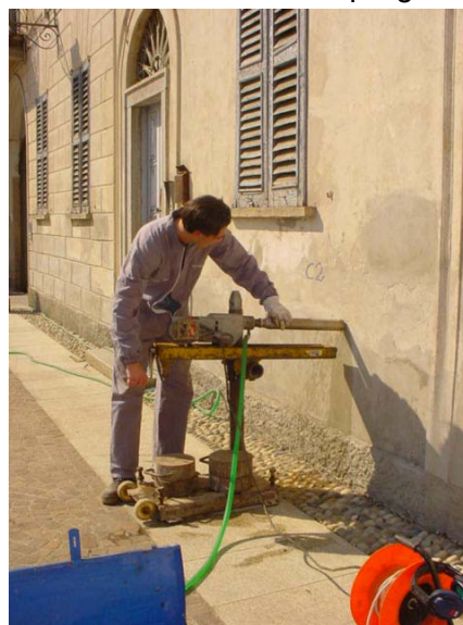
Figura 2. Esecuzione di un carotaggio.
