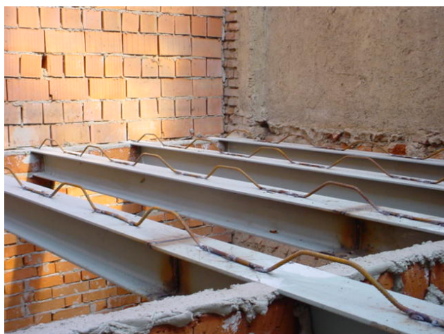
Figura 8. Nuovo solaio metallico con ferri di connessione sagomati.
