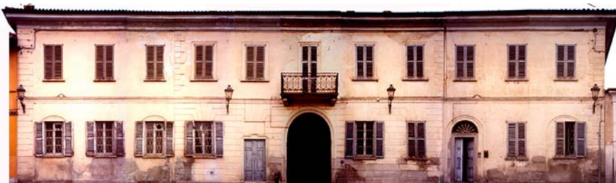
Figura 1. Il fronte dell'ex Palazzo ACLI .
