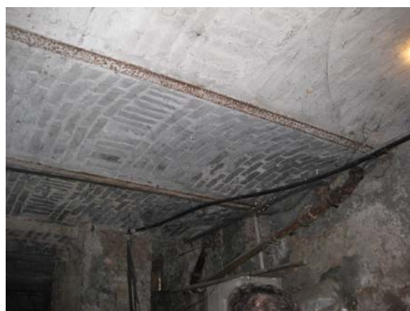
Figura 3. Solaio al piano terra in volterrane.
