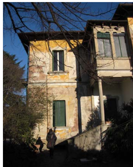
Figura 1. Prospetto esterno della Villa ex Cotonificio.
