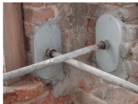
Figura 2. Capichiave delle catene interne poste nella parte alta.
