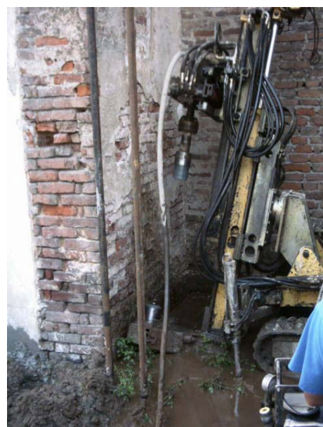
Figura 3. Inserimento dei micropali.
