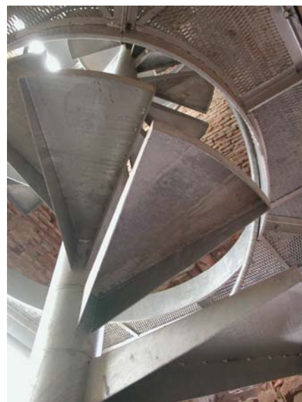
Figura 4. La scala a chiocciola e i pianerottoli in metallo interni al campanile.
