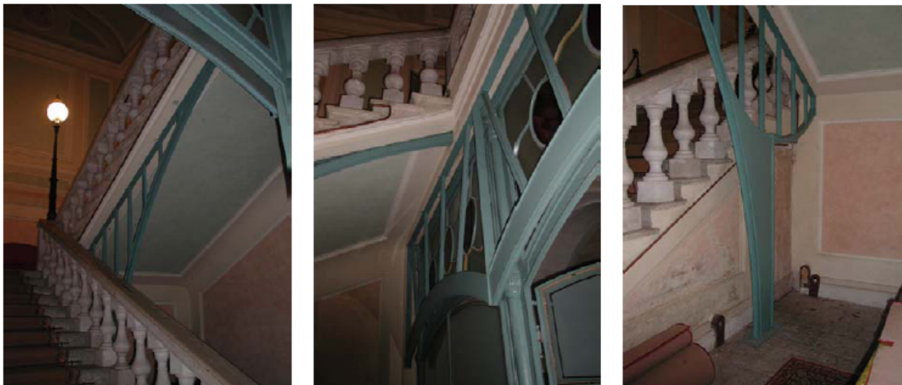
Figura 3. Immagini dell'intervento di consolidamento dello scalone interno.
