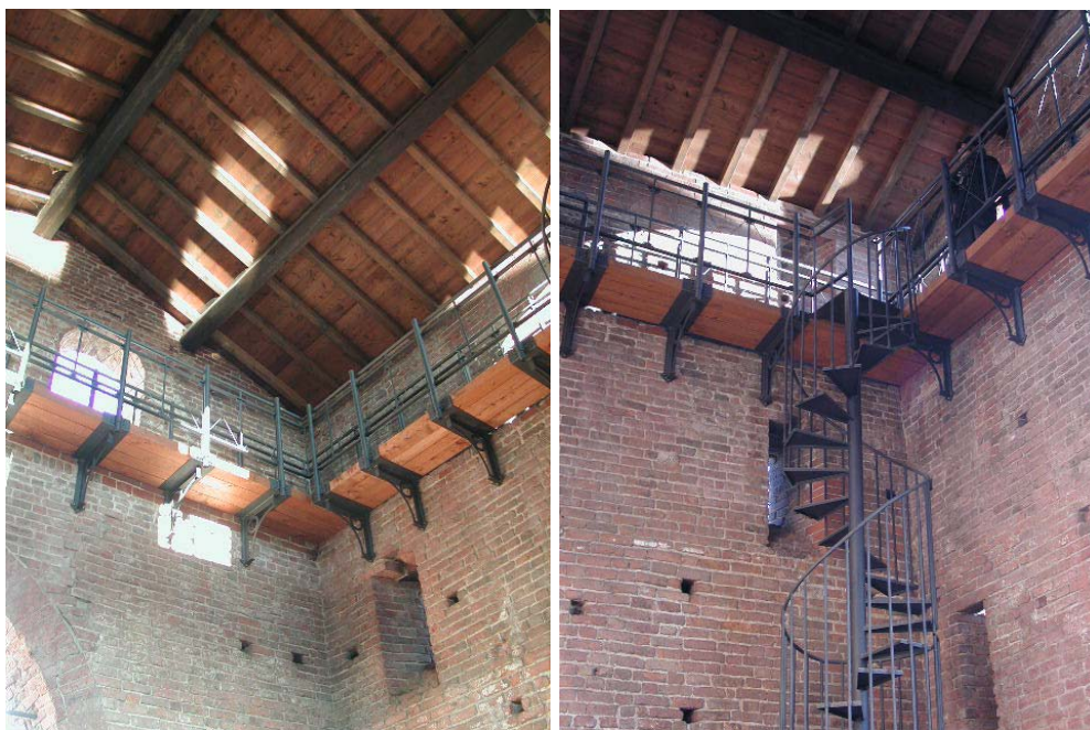
Figura 2. Viste interne del soppalco con funzione di cerchiatura delle murature.
