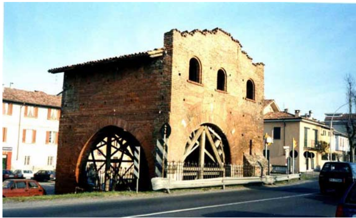
Figura 1. Vista di Porta Nuova prima degli interventi di consolidamento.
