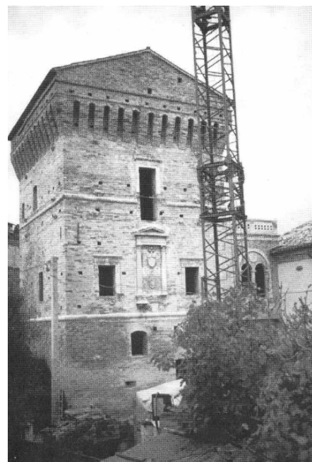
Figura 1. la torre durante l'intervento.
