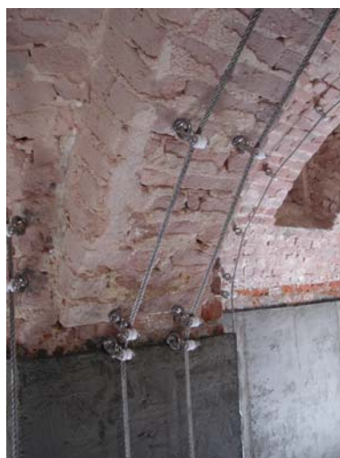
Figura 2. Arco armato intradossale.
