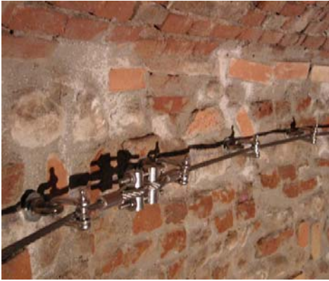
Figura 4. Cerchiatura della ghiacciaia con cavi tesati.
