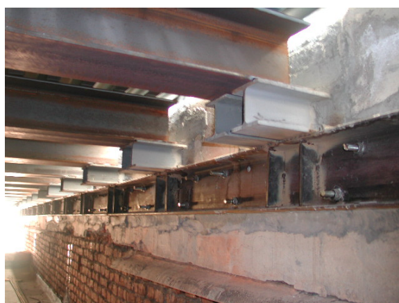
Figura 3. Nuovo solaio in acciaio e cls.
