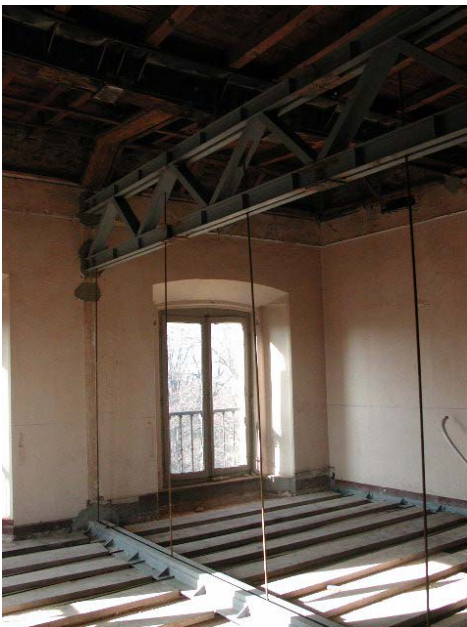
Figura 5. Nuovo solaio appeso.
