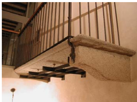
Figura 2. Rinforzo dei ballatoi in pietra.
