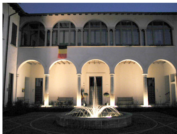
Figura 1. Prospetto interno della villa con il loggiato consolidato.
