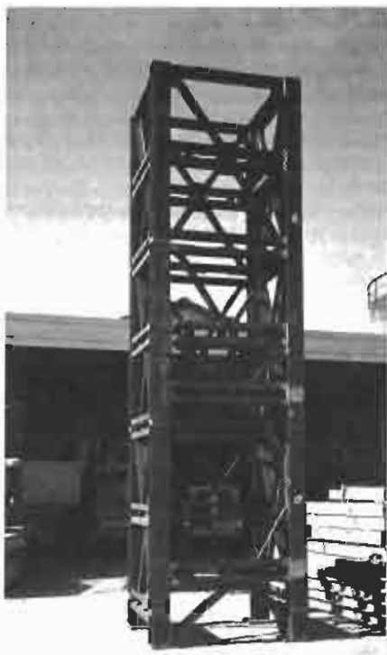
Fig.6 - Porzione inferiore del traliccio in acciaio, preassemblato in officina
