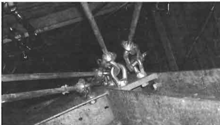
Fig.7 - Tiranti inclinati per il trasferimento dei carichi, inseriti nell'intercapedine tra la torre in muratura e la torre metallica
