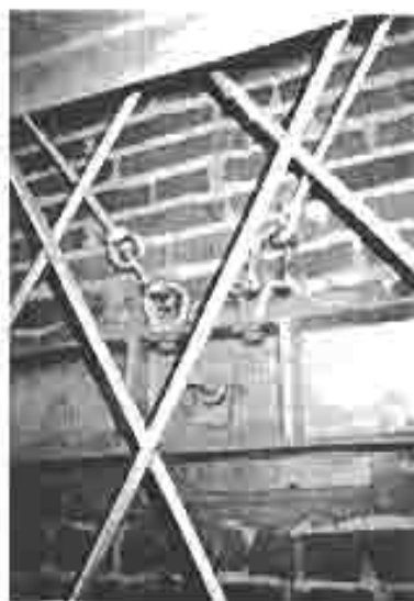
Tiranti inclinati per il trasferimento dei carichi: ancorati nell'intercapedina tra torre e muratura - particolari
