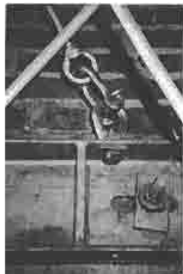
Tiranti inclinati per il trasferimento dei carichi: ancorati nell'intercapedina tra torre e muratura - particolari
