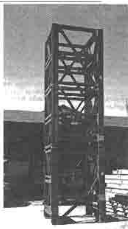
Portione inferiore del traliccio in acciaio, assemblato in officina
