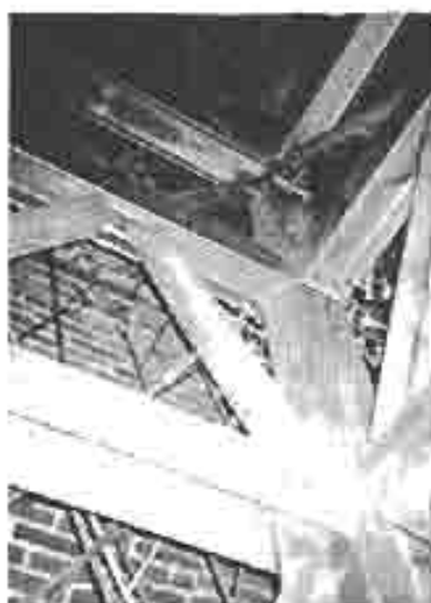
Tiranti inclinati per il trasferimento dei carichi: ancorati nell'intercapedina tra torre e muratura - particolari
