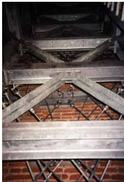
Figura 3. La "torre metallica" interna, particolare dei pendini
