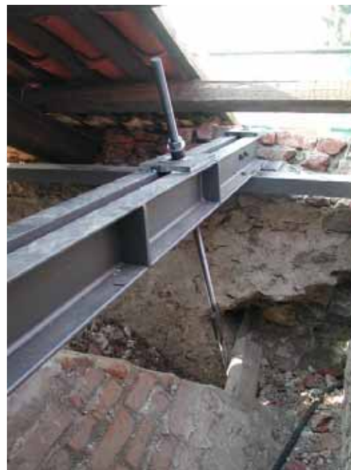
Figura 17. Particolare della "graffetta" metallica di contrasto alla spinta della volta
