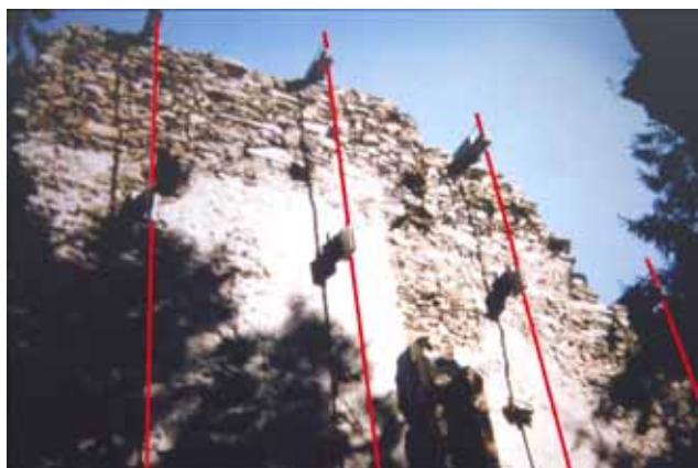
Figura 4 Consolidamento con cavi esterni post compressi verticali realizzato a Forte Fuentes
