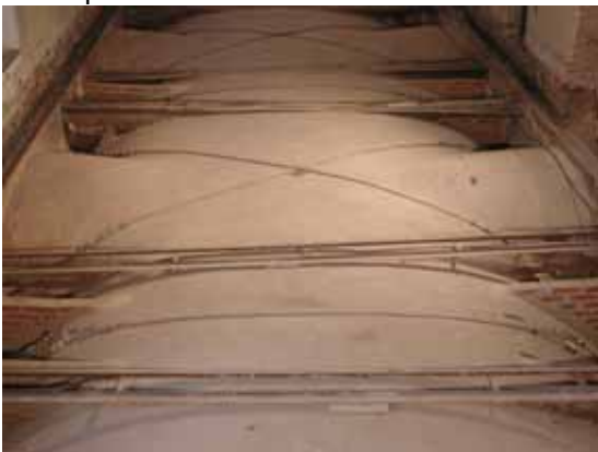
Figura 12 Casa Jacobbe, a Magenta: archi armati, tesi mediante tenditori di estremità
