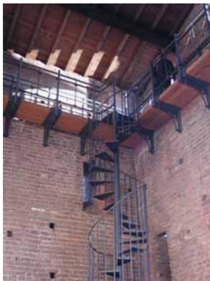
Figura 8 La trave-passerella di Porta Nuova a Pavia, realizzata in acciaio con un piano di calpestio in legno di forte spessore, è un elemento capace di ammorsare tra loro le pareti perimetrali e di vincolarle orizzontalmente
