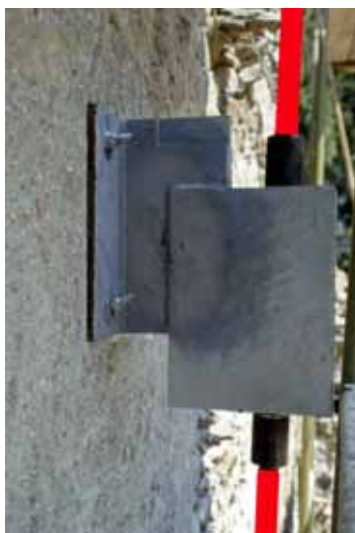
Figura 5 Dettaglio del collegamento realizzato tra il cavo e la muratura
