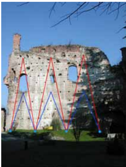
Figg. 6, 7 Intervento di messa in sicurezza provvisoria di una parete del Castello di Trezzo d'Adda . Si è optato per un consolidamento costituito da una doppia serie di "stralli" diagonali incrociati che controventano la parete sui due fronti. La presenza di buche puntaie passanti anche in questo caso facilita la posa reversibile dei cavi.
