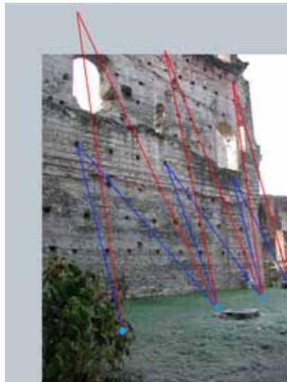
Figg. 6, 7 Intervento di messa in sicurezza provvisoria di una parete del Castello di Trezzo d'Adda . Si è optato per un consolidamento costituito da una doppia serie di "stralli" diagonali incrociati che controventano la parete sui due fronti. La presenza di buche puntaie passanti anche in questo caso facilita la posa reversibile dei cavi.
