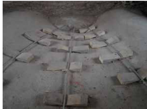
Figura 12 Casa Jacobbe, a Magenta: archi armati, tesi mediante tenditori di estremità
