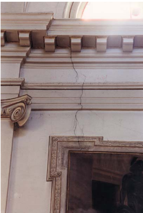
Figure 6 e 7 L'interno della chiesa di S. Francesco: particolare di una delle lesioni che si sono riaperte
