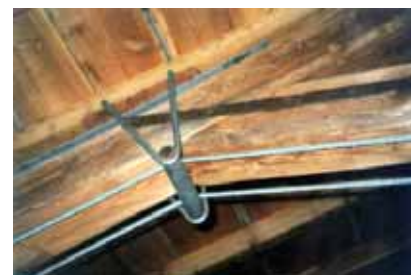
Figura 1. Complesso rurale "ex-Masciadri: soluzione di consolidamento per la copertura.
