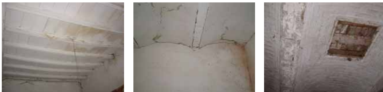
Figura 4. a) Esempio di solaio ligneo a semplice orditura; b) solaio con profili metallici e voltine in laterizio; c) solaio con nervature in cls armato e voltine in laterizio.
