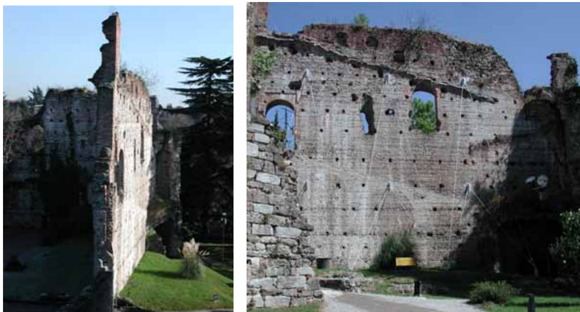
Figura 5. Il maschio murario prima e dopo l'intervento.
