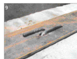
7. Prova di carico della trave reticolare mista. Si osservano le barre diagonali inghisate con resina epossidica. 8. Ubicazione dei comparatori centesimali e posizione. 9. Particolare del fissaggio tra le barre diagonali ed il corrente superiore costituito da un piatto metallico.
