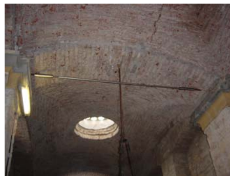
Fig. 10 – la catena al termine della posa
