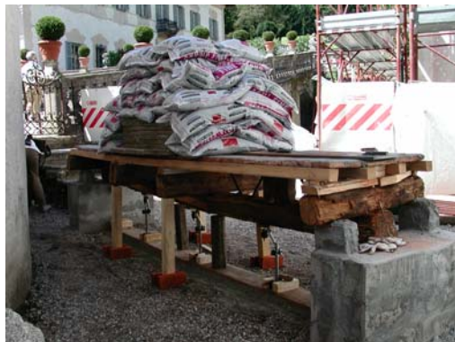
Figura 4 Villa Della Porta Bozzolo, Casalzuino (VA): prove di carico: fase di carico su trave campione.
