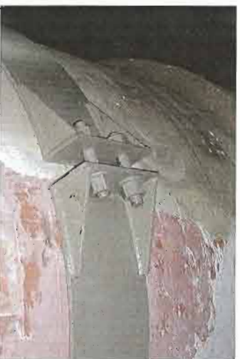
Figure 1, 2, 3 - Immagini di cerchiature con fasce in acciaio delle colonne d'ingresso della Camera di Commercio di Catania e delle colonne affrescate interne dell'abbazia di Chiaravalle a Milano
