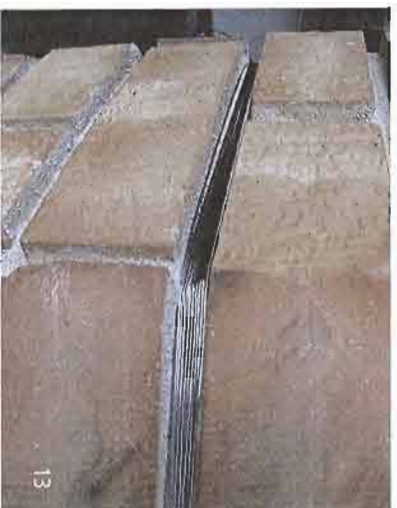
Figure 11, 12, 13 - Cerchiatura con fili in acciaio, mascherabili all'interno dei giunti di malta, dei pilastri in muratura delle prove sperimentali condotte
