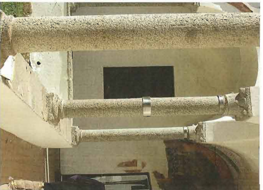
Figure 4, 5 - Cerchiature delle colonne del chiostro dell'ex Monastero di San Michele a Lonate Pozzolo
