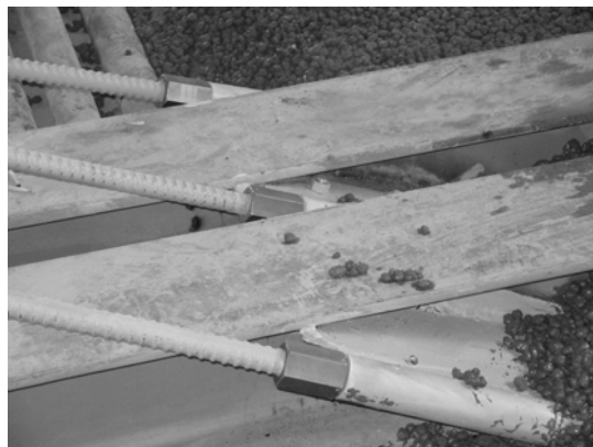
Fig. 6: Palazzo delle Carrozze a Masino, particolare dell'unione tiranti-trave
