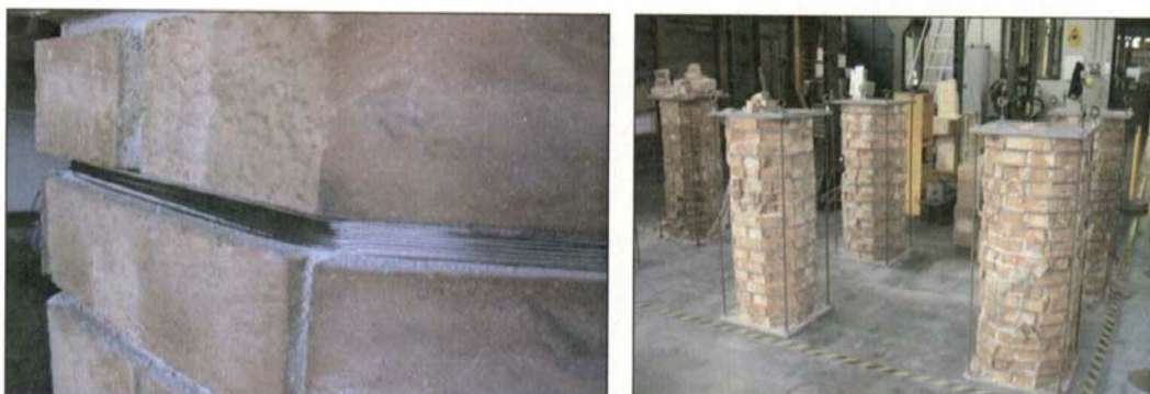
Figura 6 – Cerchiatura di colonne in muratura con cavi ubicati nei giunti
