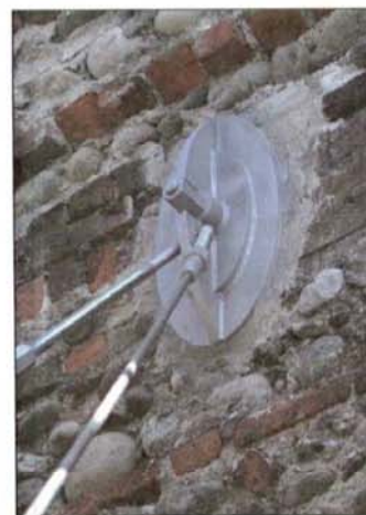
Figura 2 - Una parete del Castello di Trezzo sull'Adda consolidata con stralli a V rovescia
