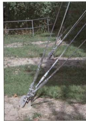
Figura 2 - Una parete del Castello di Trezzo sull'Adda consolidata con stralli a V rovescia
