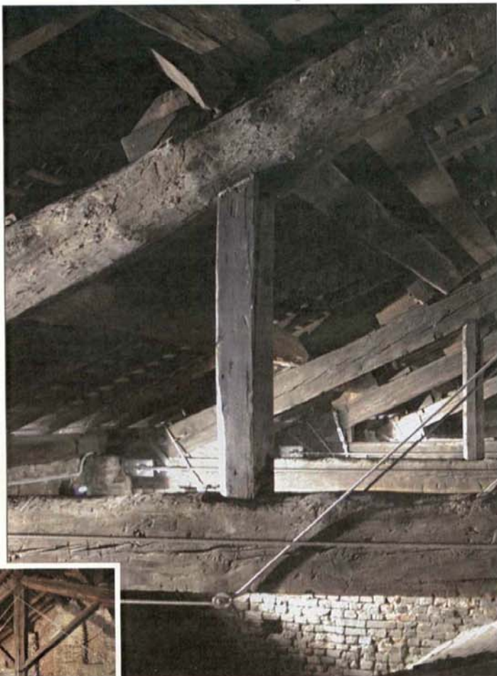
Figura 1 - Puntelli e cavi per il consolidamento delle capriate della Chiesa di San Carpoforo a Milano
