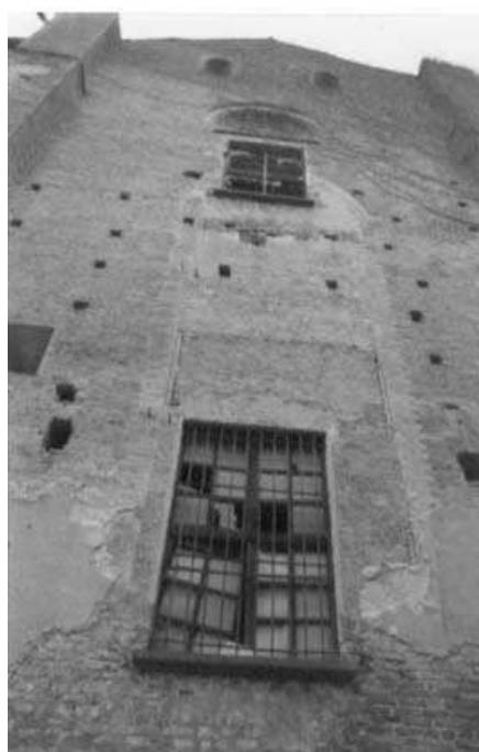
Fig. 2: Vista esterna del transetto meridionale prima degli interventi di restauro
