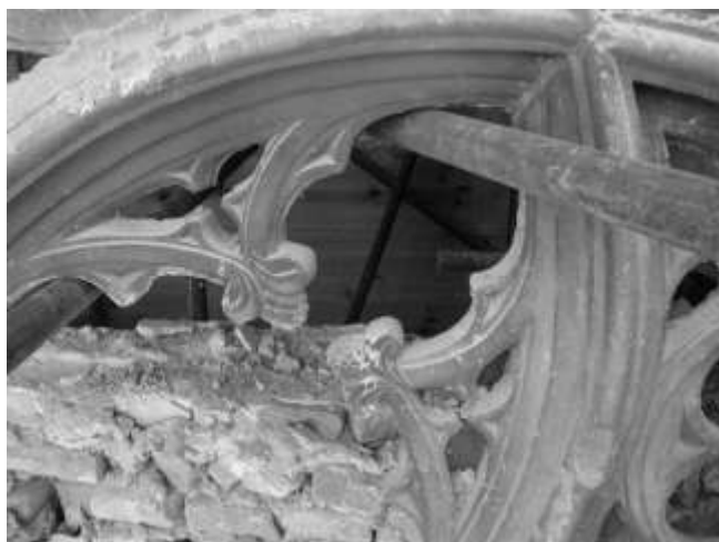
Fig. 3: Modanature ritrovate a seguito della rimozione del tamponamento
