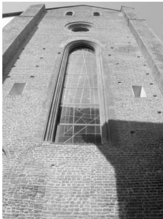
Fig. 4: Vista dall'esterno del serramento strutturale sulla monofora restaurata
