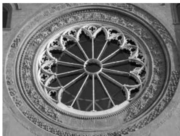
Fig. 11: Vista esterna del rosone: l'intervento di raggiera metallica risulta evidente ma adeguatamente integrato con la facciata restaurata
