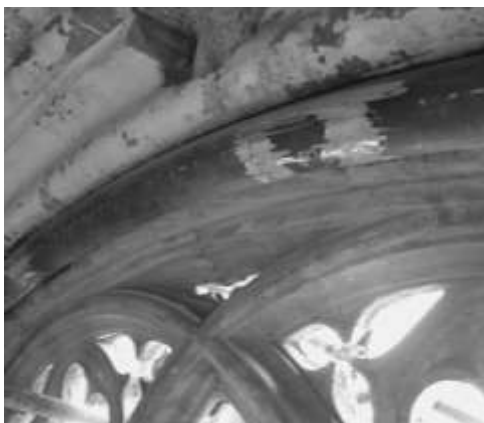
Fig. 6: Dettaglio dell'anello di rinforzo
