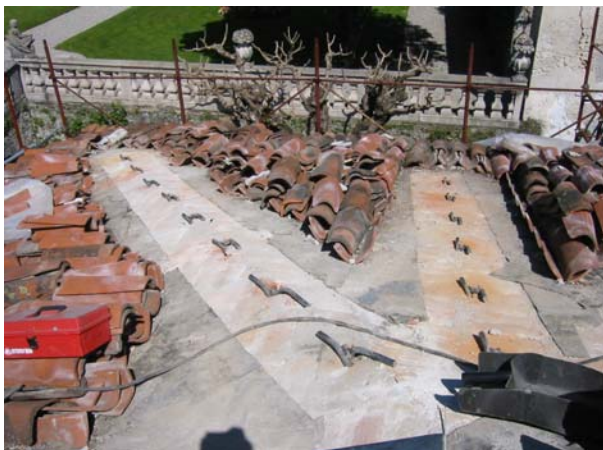
Figura 4. Vista estradossale dei connettori.
