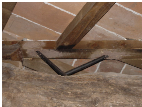
Figura 3. Dettaglio del consolidamento delle coperture mediante connettori metallici a formare una "reticolare".
