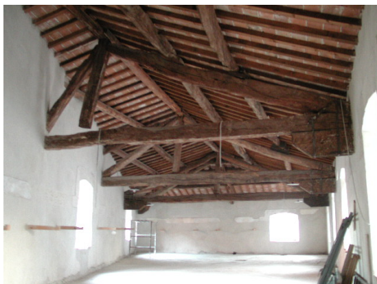
Figura 2. Vista interna dalla sala coperta da strutture lignee.
