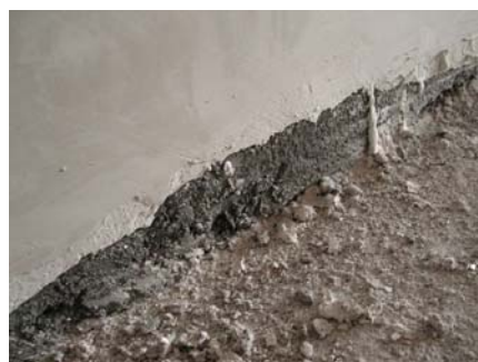
Figura 3. Consolidamento delle murature mediante "gunite" armata.
