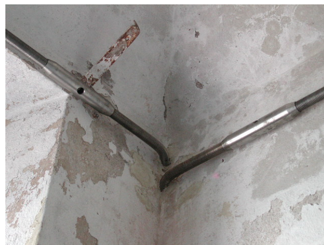
Figura 2. Tiranti interni di consolidamento delle murature.
