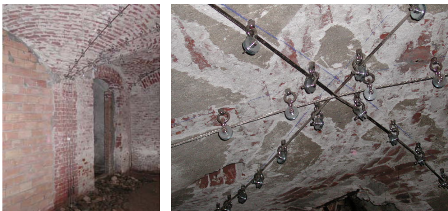
Figura 3. Consolidamento delle volte in muratura con "arco armato" intradossale.
