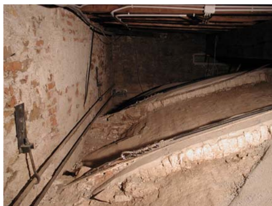
Figura 3. L'"arco armato" e la cerchiatura estradossale alla volta del Salone delle Grottesche.
