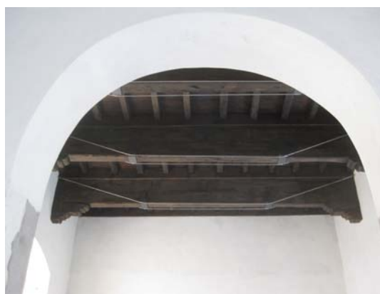
Figura 8. Interventi di rinforzo di alcune travi lignee.
