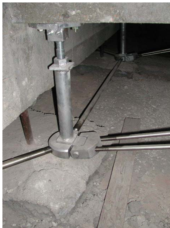
Figura 2. Dettaglio dei puntoni metallici di sostegno al reticolato in c.a. esistente.
