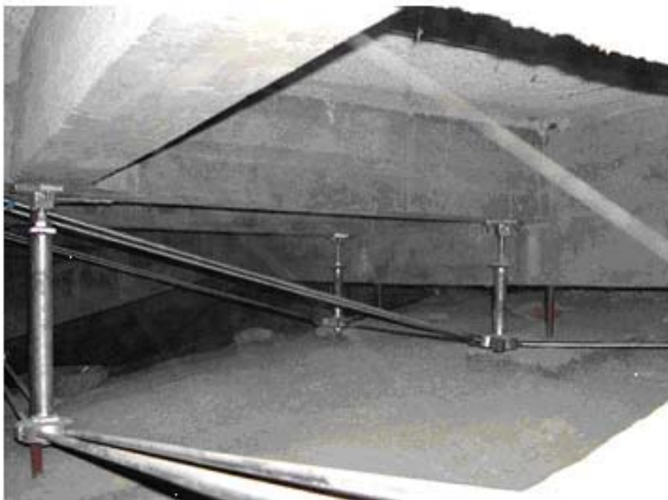
Figura 4. Cavi e puntoni in acciaio inox posti all'estradosso della volta.
