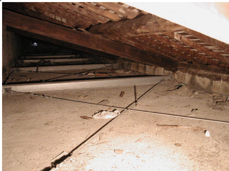
Figura 5. Intervento di controventamento del sottotetto realizzato attraverso cavi e barre; la particolare disposizione per mettere di ottenere un comportamento reticolare coinvolgente le murature stesse sollecitate a compressione.
