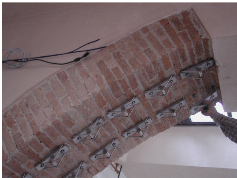
Figura 6. Montaggio e vista dell'"arco armato" intradossale.
