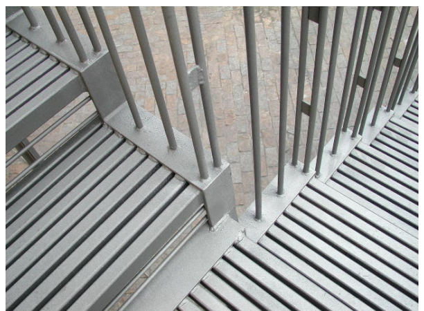
Figura 4. La scala di emergenza in carpenteria metallica.
