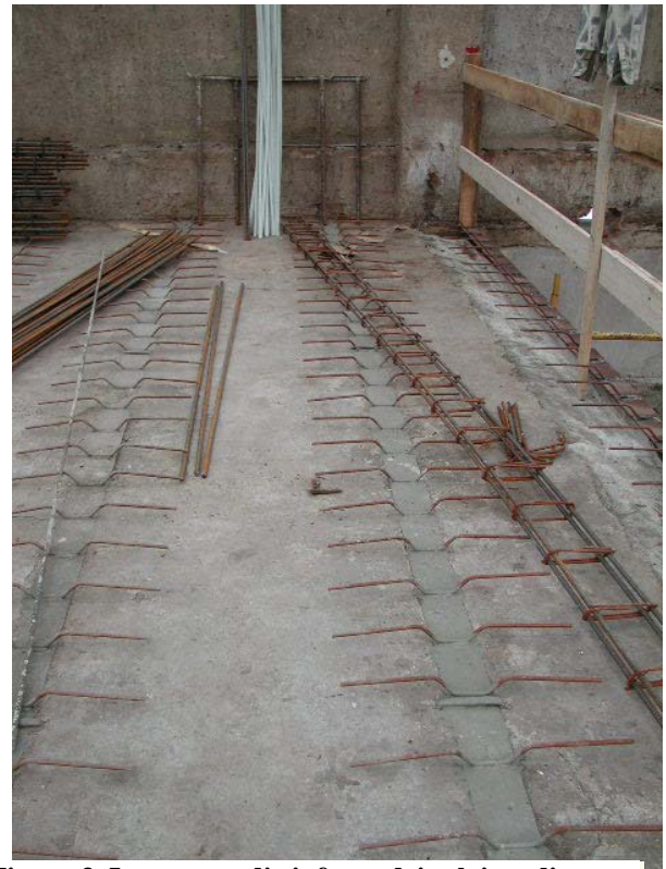
Figura 3. Intervento di rinforzo dei solai mediante getto in cls e connettori metallici piegati.
