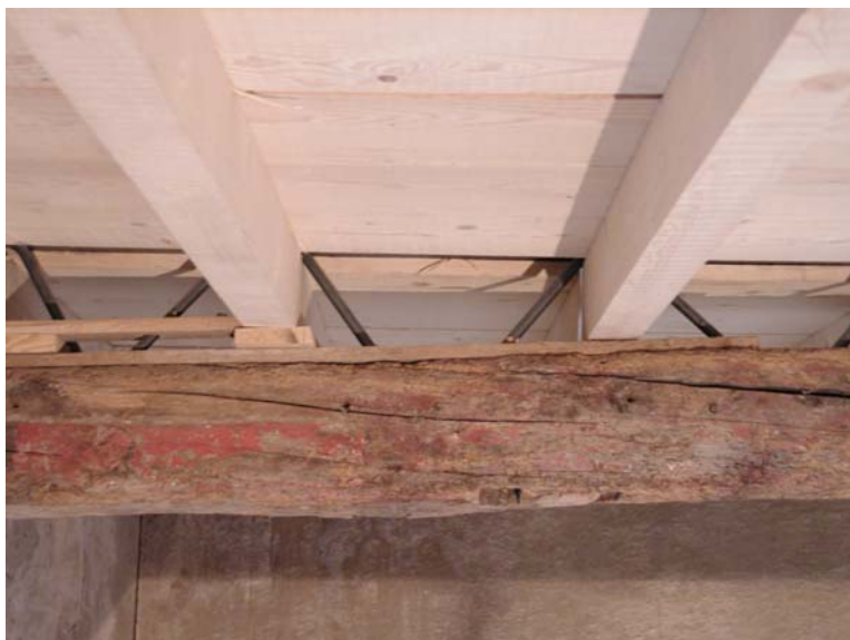
Figura 4. Consolidamento delle travi lignee mediante connettori metallici a traliccio.
