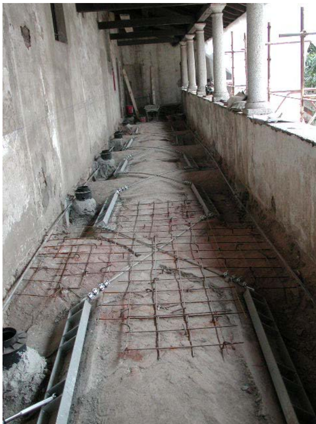
Figura 3. Consolidamento delle volte con "arco armato".
