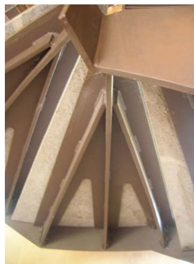
Figura 4. Consolidamento delle travi lignee mediante connettori metallici a traliccio.
