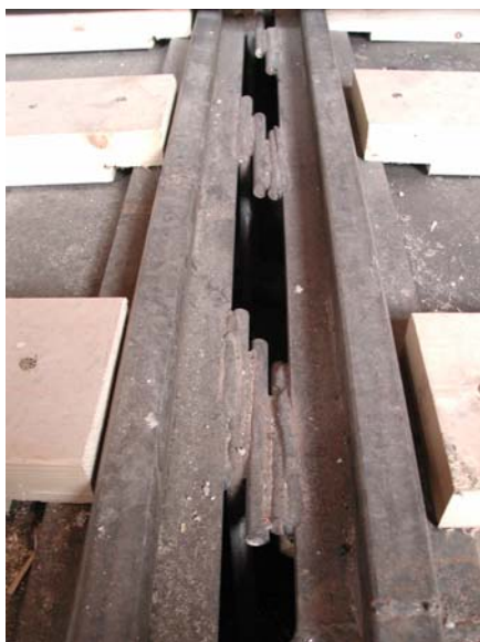
Figura 4. Consolidamento delle travi lignee mediante connettori metallici a traliccio.
