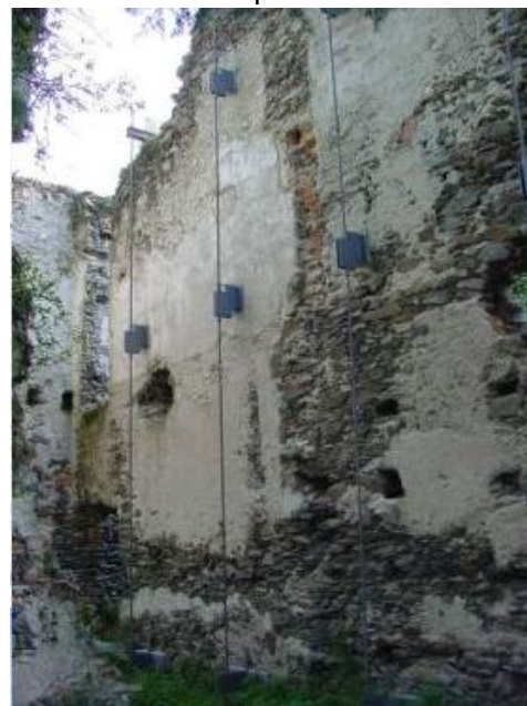
Figura 2. Intervento di consolidamento delle murature mediante cavi e piastre metalliche.
