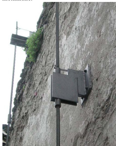
Figura 3. Dettaglio di ancoraggio dei cavi alla muratura.
