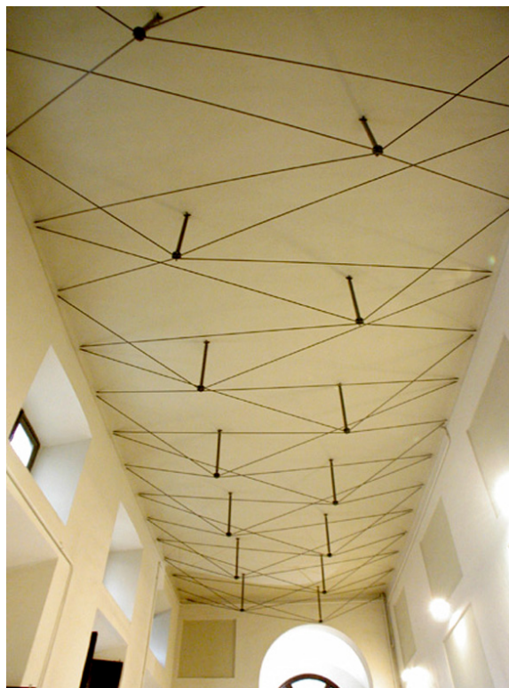
Figura 2. Vista generale del solaio consolidato.
