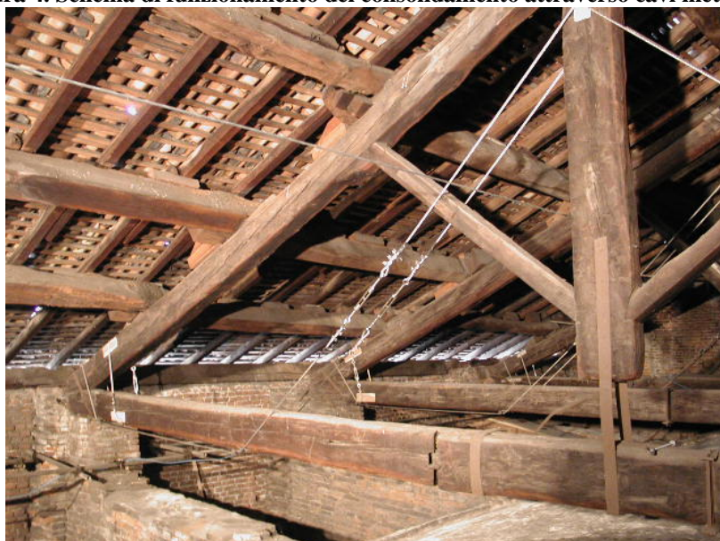
Figura 5. Realizzazione dell'intervento sulle capriate.
