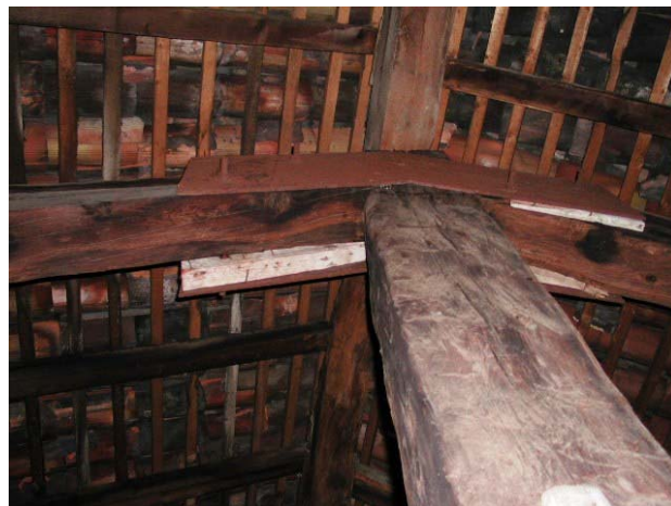
Figura 3. Consolidamento dei nodi delle capriate mediante "fettoni" in legno.
