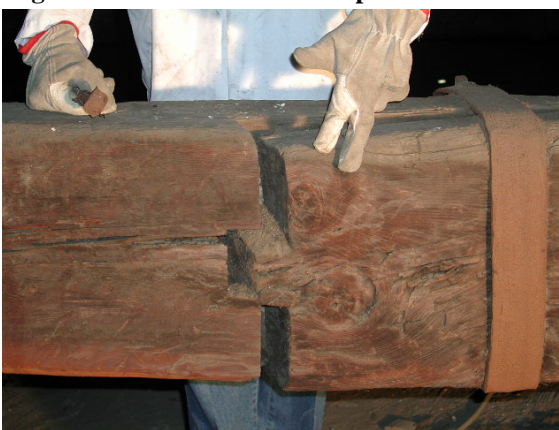
Figura 2. Giunto a "dardo di Giove" della catena lignea.
