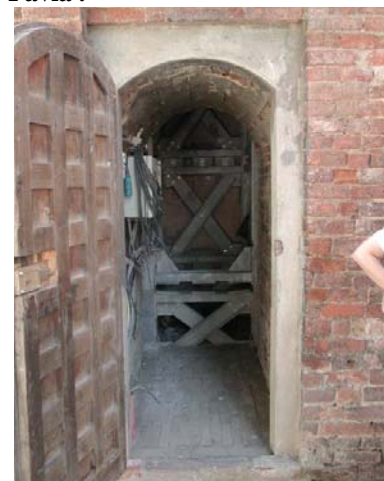
Figura 2. Ingresso alla torre con la struttura metallica interna di consolidamento e di sostegno del montacarichi.
