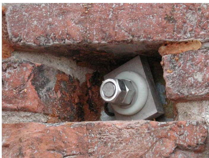
Figura 3. Ancoraggio delle barre metalliche alle buche pontai.
