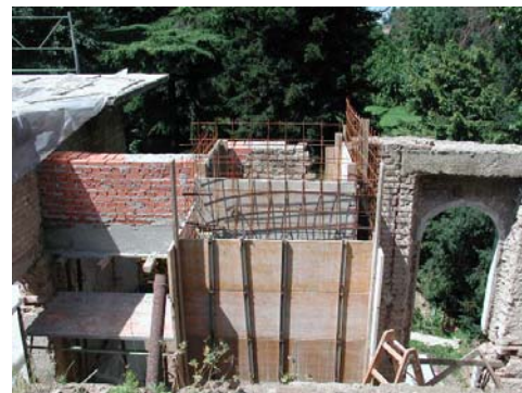
Figura 2. Vista generica durante la fase di consolidamento.
