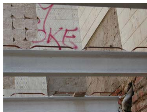
Figura 3. Travi NP con connettori metallici sagomati.
