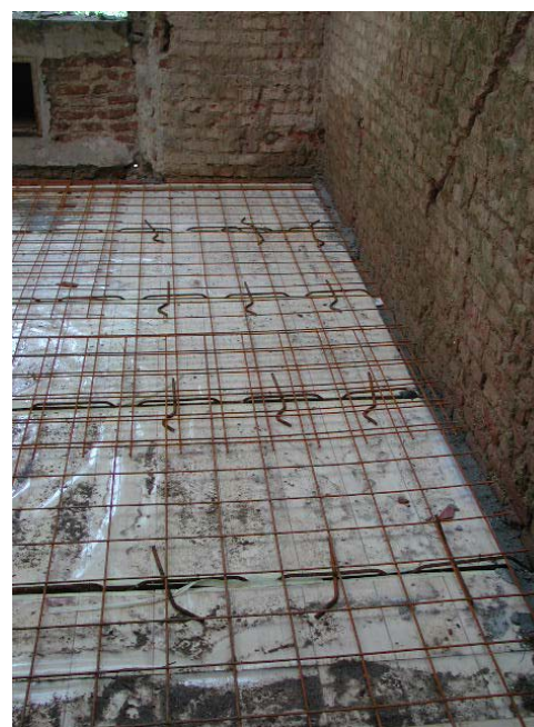
Figura 4. Nuova soletta in c.a.; in evidenza i connettori sagomati saldati alle travi NP.
