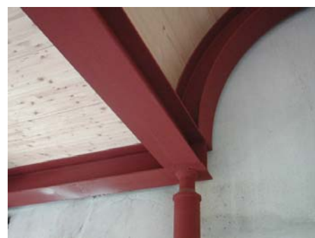
Figura 5. Vista e dettaglio della struttura metallica del "giardino d'inverno".
