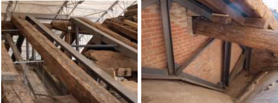
Figura 6. Immagini delle “travi boomerang”
