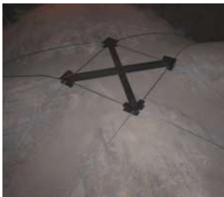
Figura 10. Arco armato realizzato con cavi incrociati “a stella” al di sopra delle cupole dei transetti.
