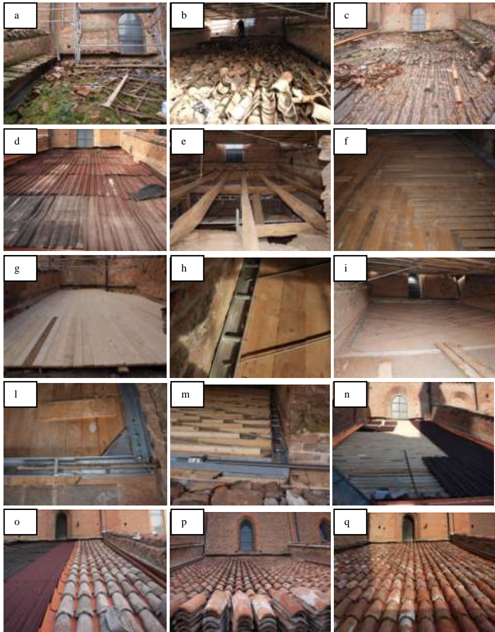
Figura 11. Interventi sulle coperture: copertura esistente con strati di tegole sovrapposti e guaina ondulata bitumata (a,b,c,d); orditura lignea esistente (e); nuovo doppio assito incrociato (f,g); controventi in acciaio con cornice perimetrale (h,i,l,m); nuova copertura composta da guaina impermeabilizzante, ondulina sottocoppo e coppi di recupero integrati e dotati di ganci ferma coppo (n,o,p,q).
