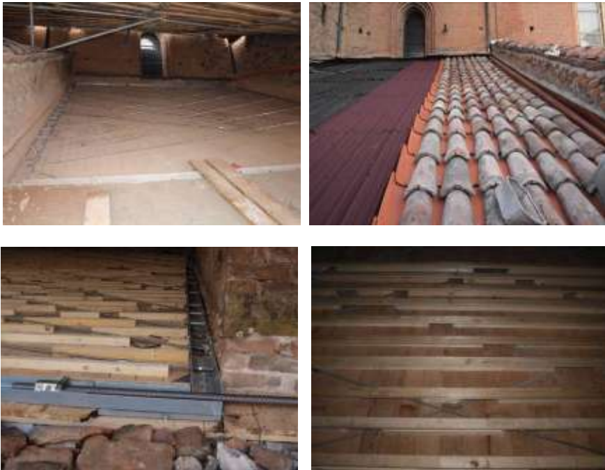
Figura 16. Consolidamento delle coperture del Duomo di Cremona con la creazione di diaframmi rigidi di falda
