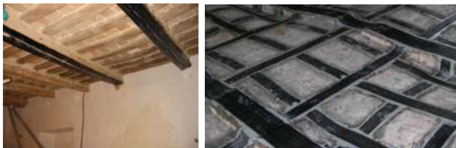
Figura 13. L'uso di FRP nel consolidamento di elementi lignei e in muratura
