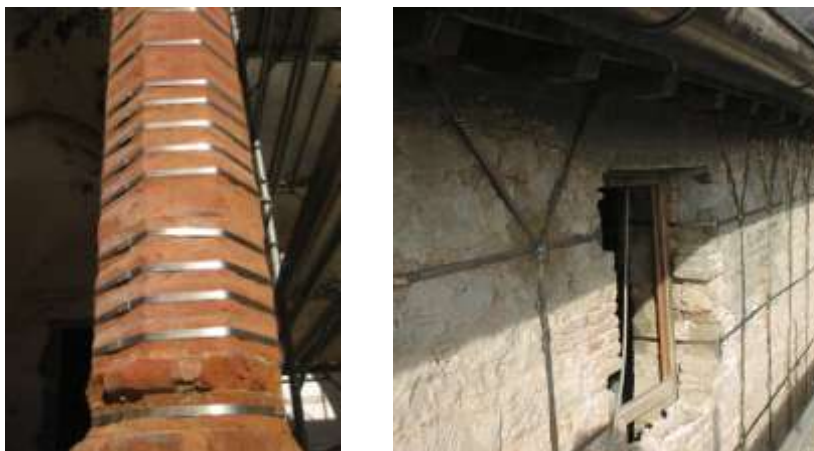
Figura 14. Cerchiatura esterna con bandelle in acciaio inox di una colonna in muratura e confinamento di una parete in muratura (metodo CAM)
