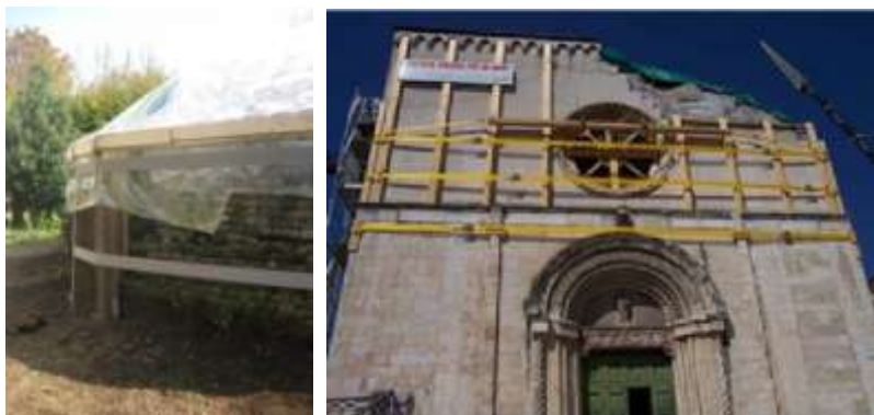
Figura 20. Opera di messa in sicurezza mediante fasce in poliestere della Ghiacciaia di Villa Arconati a Bollate (Jurina 2011) e di una chiesa a L'Aquila
