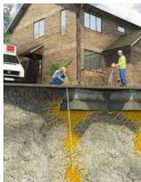
Figura 19. Consolidamento attivo mediante l'iniezione di resine espansive
