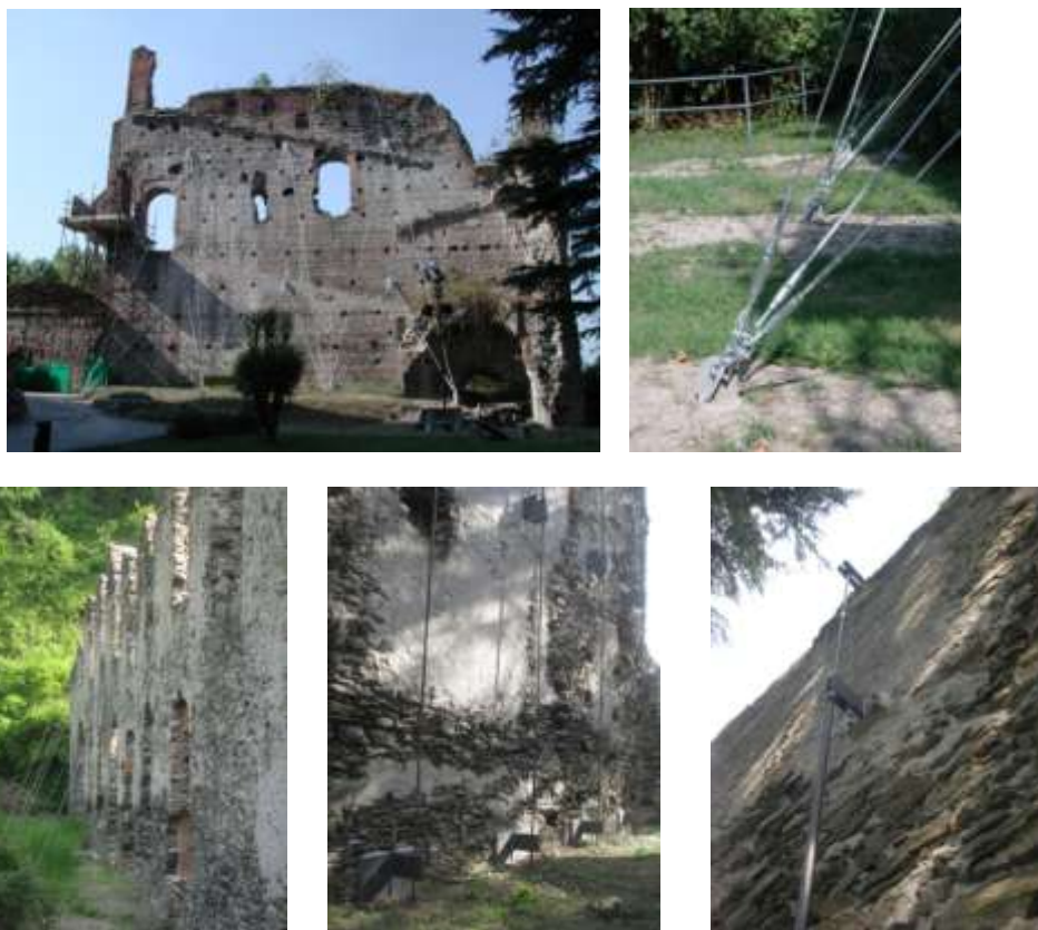
Figura 11. Una parete del Castello di Trezzo sull'Adda consolidata con stralli diagonali ed una parete di Forte Fuentes a Colico consolidata con barre verticali e stralli
