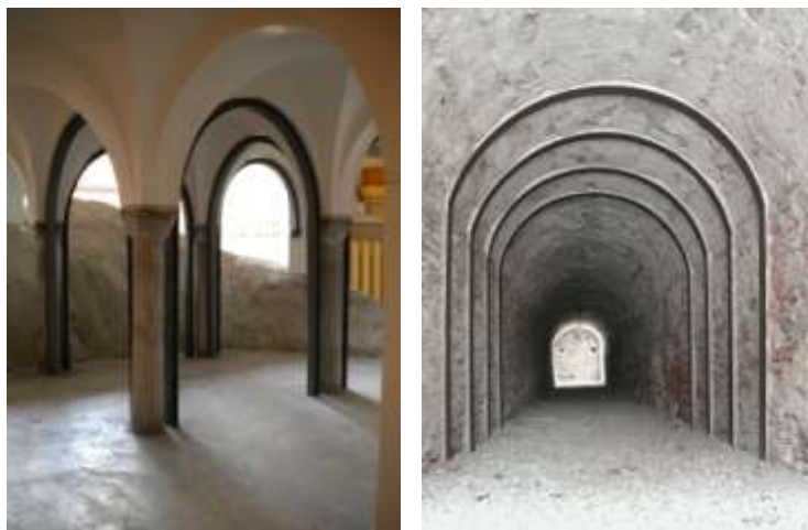
Figura 7. a) Il “gazebo strutturale” nella cripta del Sacromonte di Varese (modello Giglio -2011); b) Galleria laterale dell’”Antica Parrocchiale” del Castello della Manta
