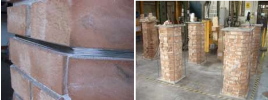
Figura 15. Cerchiatura di colonne in muratura con cavi inseriti nei giunti
